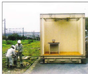
工事振動測定風景
